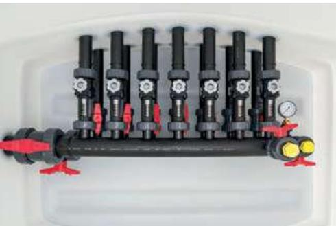
7 Sonden, Hauptabspernung, Manometer, Durchflussmesser, Füll- und Entlüftungsventil
